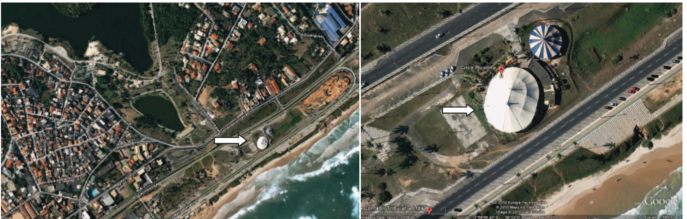
Figure 24 Image satellite de localisation école Picolino de Circo – Source Google
